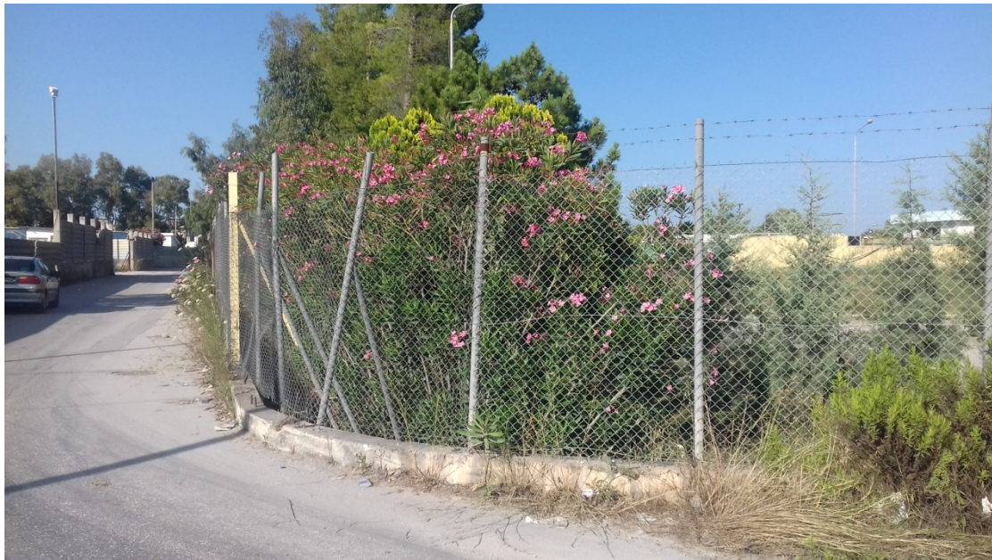
Φ1 : Υπάρχουσα περίφραξη, καμπύλη οδού Ιδομενέως και Σαχτούρη. Ζημιές από διερχόμενα βαρέα οχήματα.
