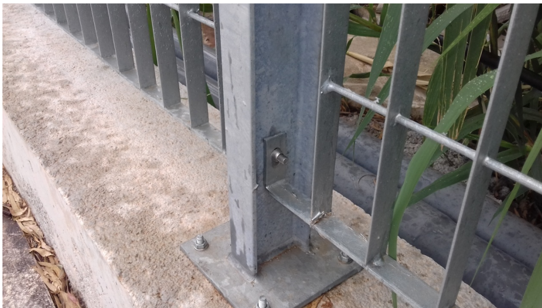
ΦΝ3 : Ενδεικτικός τρόπος σύνδεσης μεταξύ στύλων και πλαισίων. Κάτω λάμα - ωτίδα.
