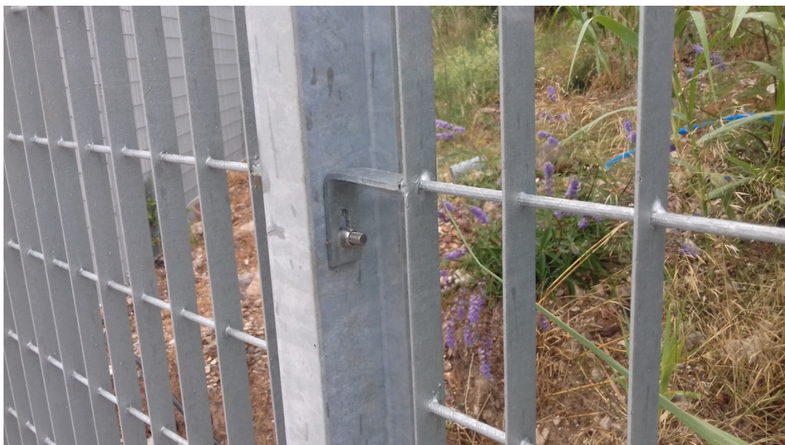
ΦΝ4 : Ενδεικτικός τρόπος σύνδεσης μεταξύ στύλων και πλαισίων. Μεσαία λάμα - ωτίδα.
